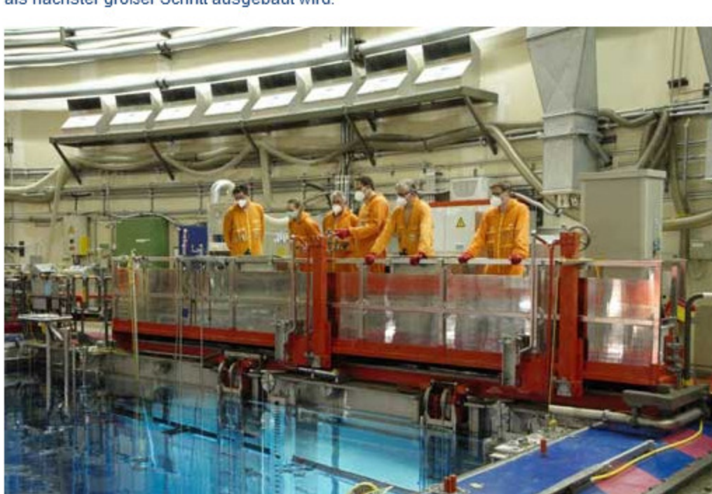
Wichtige Erläuterungen erhielt Herr Dr. Krebber auch auf der 40-Meter-Ebene im Maschinenhaus von Block B vor dem Brennelementlagerecken.
