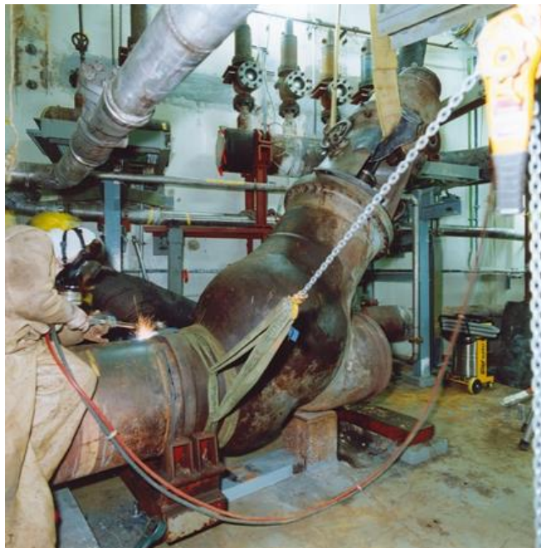
Abbildung 8: Autogenes Brennschneiden einer Absperrarmatur
