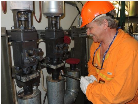
Ausbau eines Bauteils im Kontrollbereich des Block C
