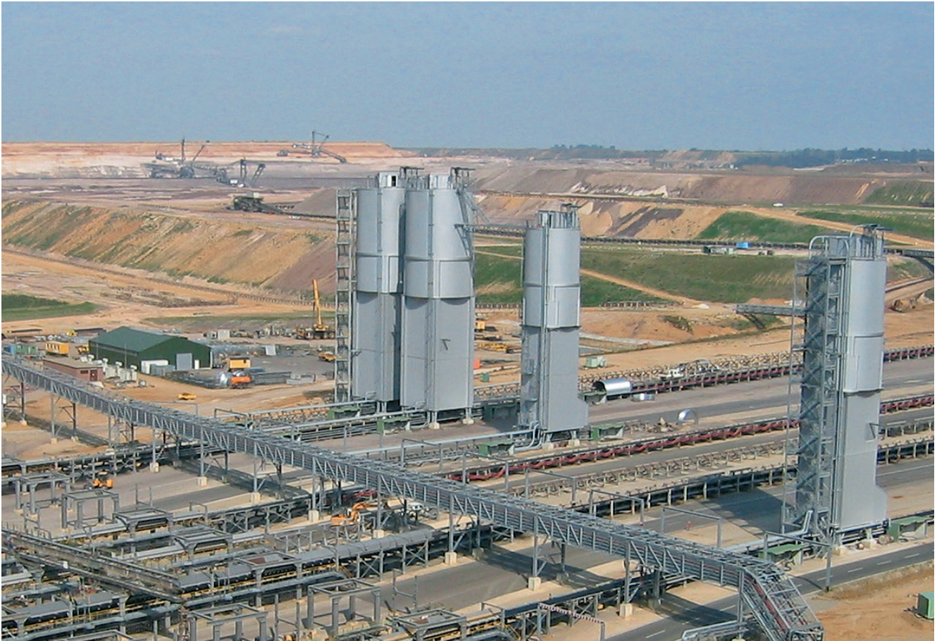
Bild 6: Silos für die Kalkzugabe auf Abraumförderbänder im Tagebau Garzweiler (Quelle: RWE Power AG)
