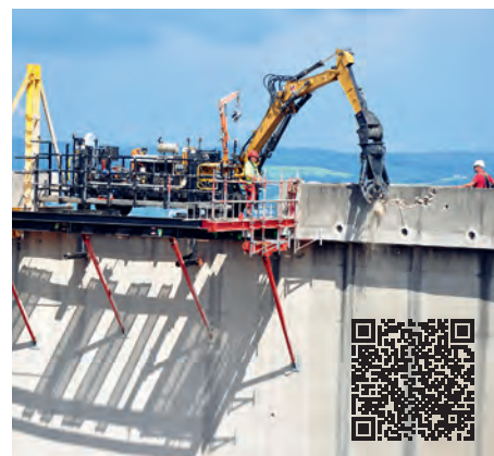
↓ RÜCKBAU: In 162 Meter Höhe beginnt der Roboter sein Nagewerk.
