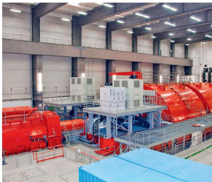
↑ IM RUHESTAND: Der für den Phasenschieberbetrieb umgerüstete Generator.
