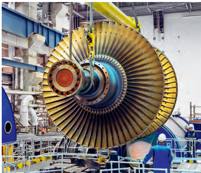
↑ SCHWERSTARBEIT: Für die Revision müssen die Turbinen aus ihrem Lager gehoben werden.
