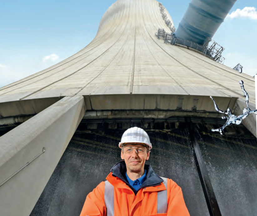
↑ KÜHLEND: Jürgen Clasen ist als Gewässerschutzbeauftragter auch für die Funktionstüchtigkeit der Kühltürme im Kraftwerk Neurath zuständig.
