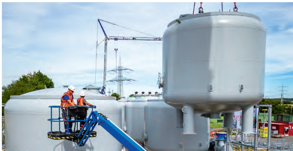
Das Wasserwerk der RWE Power in Dirmerzheim erhält neue Technik – die Versorgung mit frischem Trinkwasser läuft parallel weiter.
