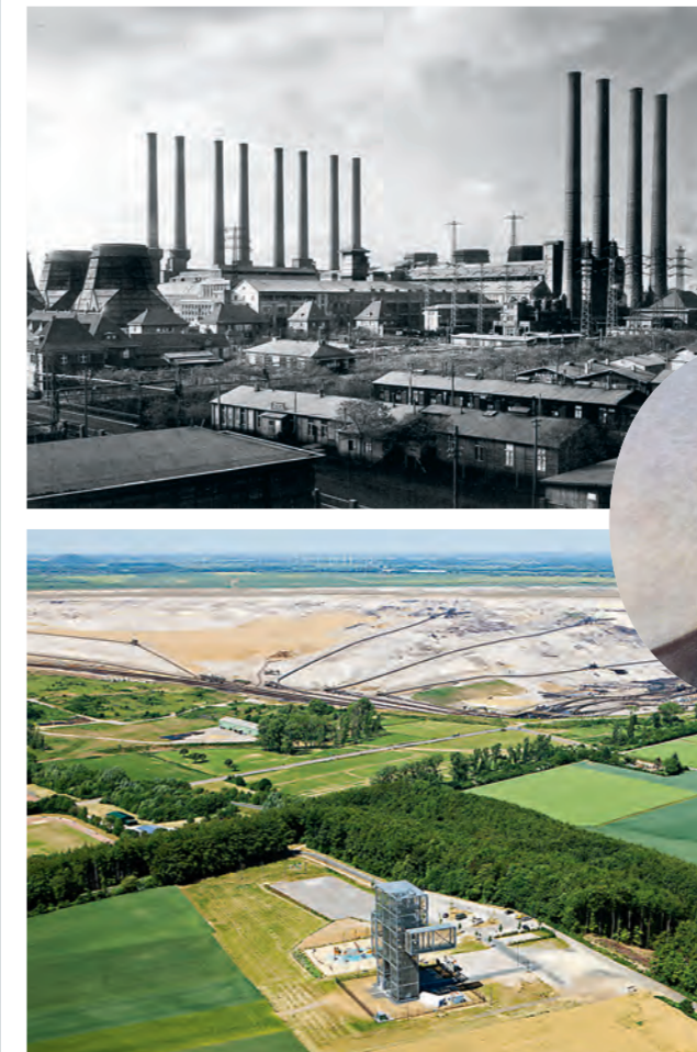
Wie alles begann: Hugo Stinnes erkannte früh das Potenzial des ersten Elektrizitätswerks in Essen.
