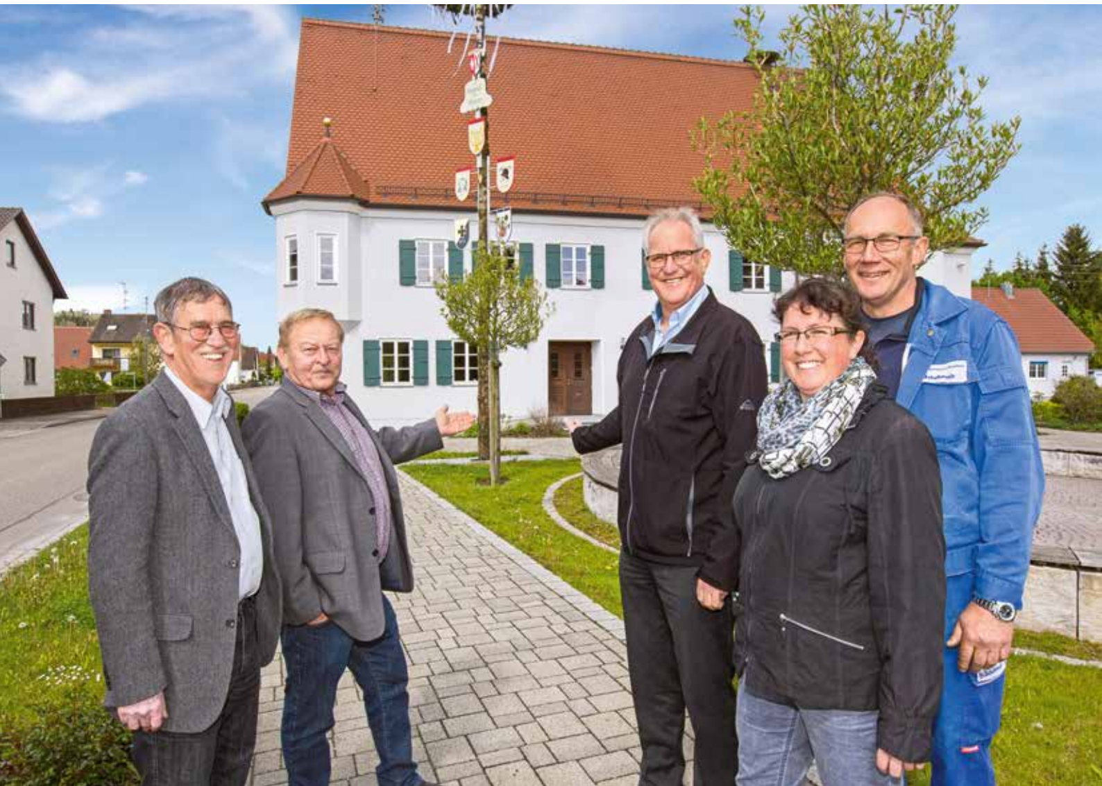
↑ VEREINSHEIM, Sitzungssaal und Treffpunkt für alle Altersgruppen: Das Mehrgenerationenhaus in Weisingen entstand in Gemeinschaftsarbeit und bietet viel Platz für das Miteinander der Generationen.
