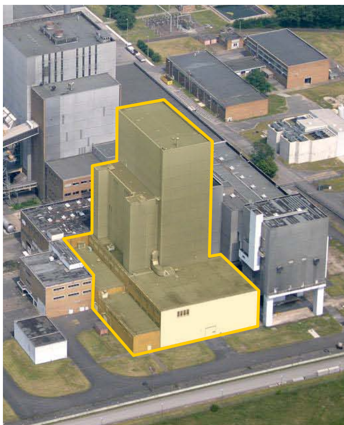
Abb. 11: Sicherer Einschluss des THTR-300
