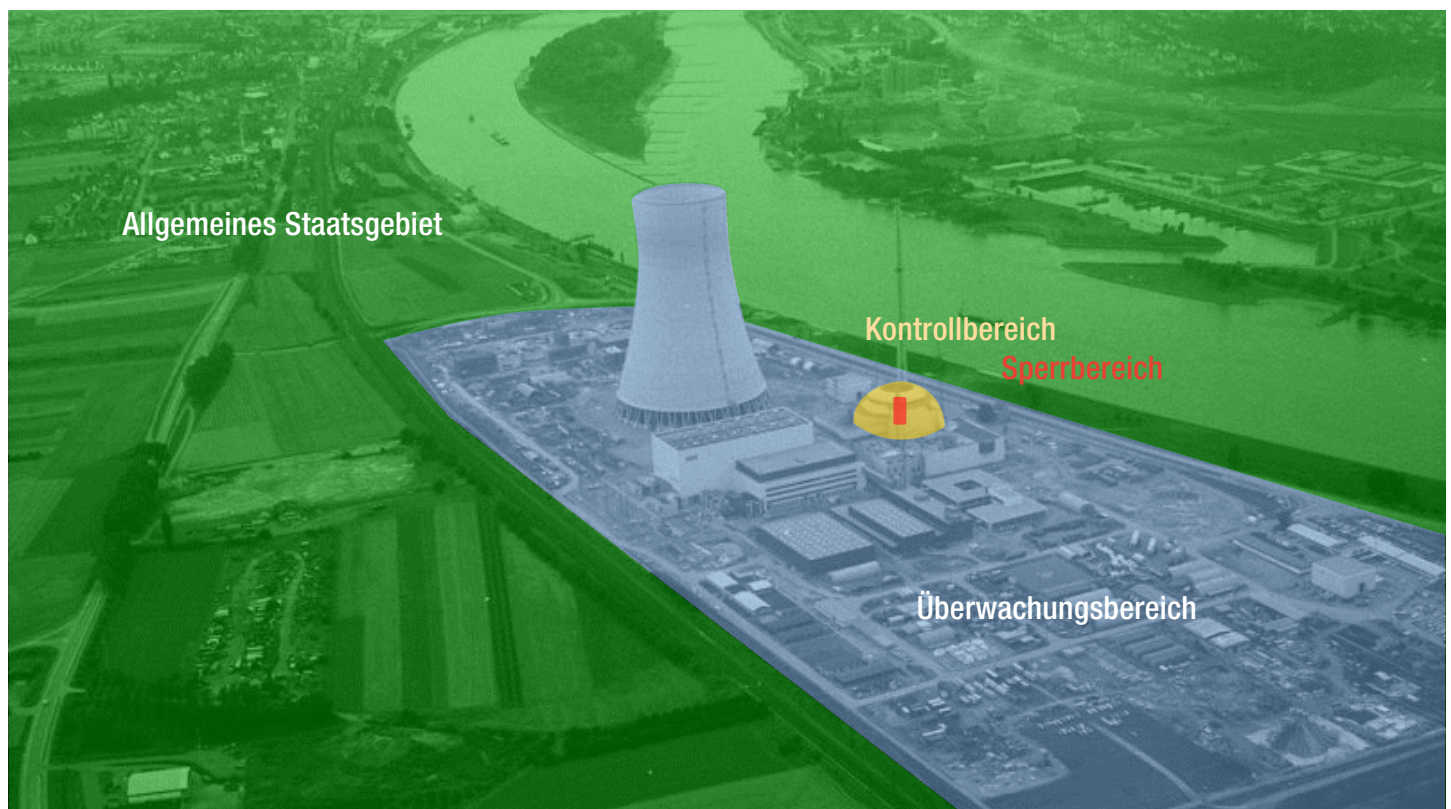
Abb. 23: Schematische Darstellung der Strahlenschutzbereiche einer kerntechnischen Anlage
