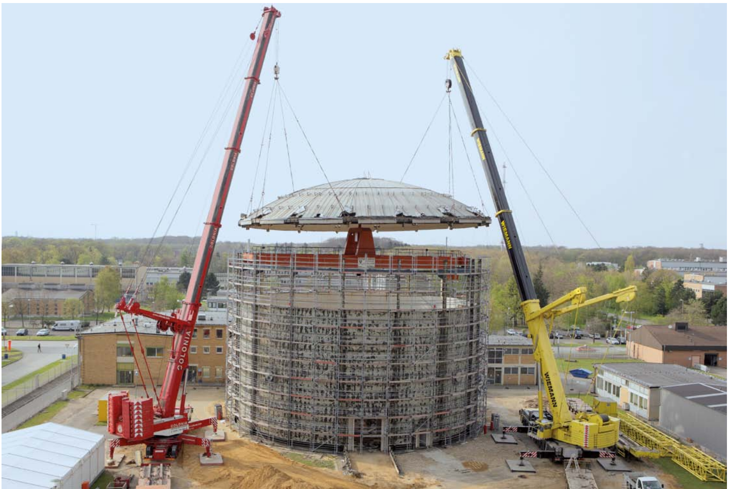
Abb. 6: Abbau des Forschungsreaktors FRJ-1
