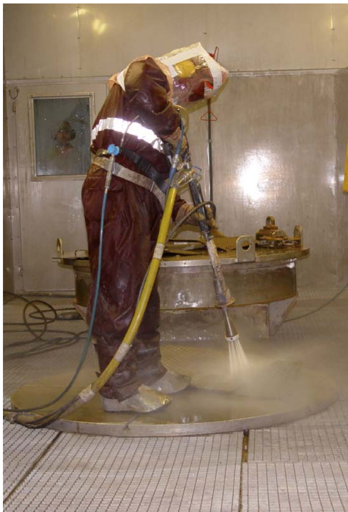
Abb. 24: Vollschutzausrüstung bei der Dekontamination mittels Hochdruckreiniger
