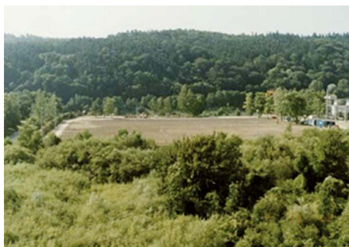
Abb. 1: Rückbau des Kernkraftwerks Niederaichbach
